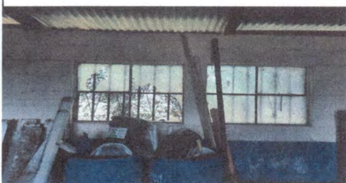
Foto 3: Sustitución de estructura de metal de ventana
